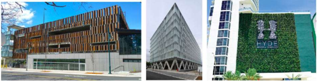
exemple de tratare a fațadelor parcărilor vizibile din circulațiile publice
